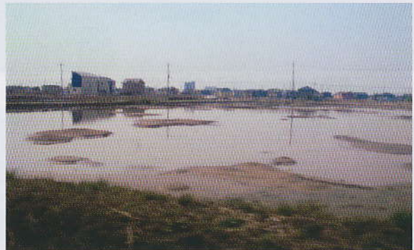
● 液状化現象で砂・水が噴出した水田
